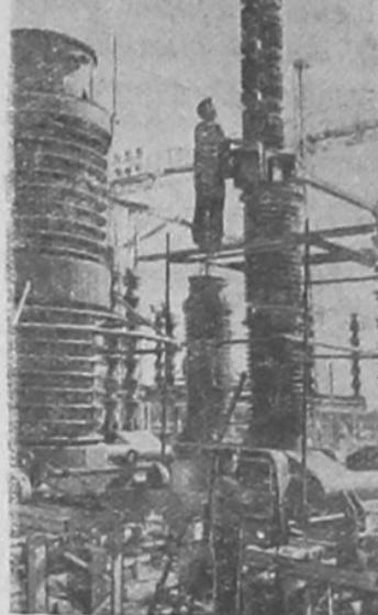
Московская область. В районе Ногинска заканчивается строительство подстанции, предназначенной для приема электроэнергии с Куйбышевской гидроэлектростанции. Первоначальное напряжение в 400.000 вольт здесь будет понижаться до 220.000 и 110.000 вольт. Подстанция полностью оснащена отечественным оборудованием.
